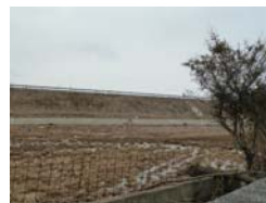
亶理町を南北に走る常磐自動車道
